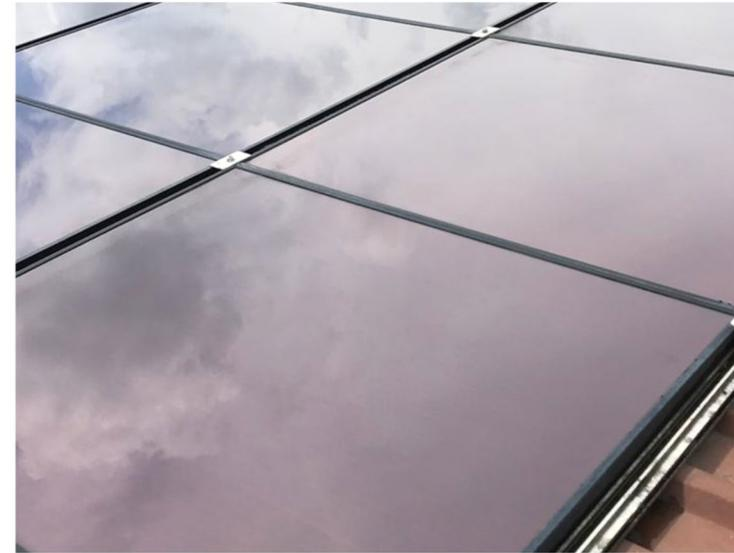
Die verkrustete Verschmutzungen, wie Moos und Flechten und auch die Verschmutzungen, die sich an den Rändern der Modulrahmen festgesetzt hatten konnte durch die Reinigung entfernt werden. Nach der Reinigung ist es dem Solarmodul möglich, die Sonnenstrahlen in Energie umzuwandeln.
