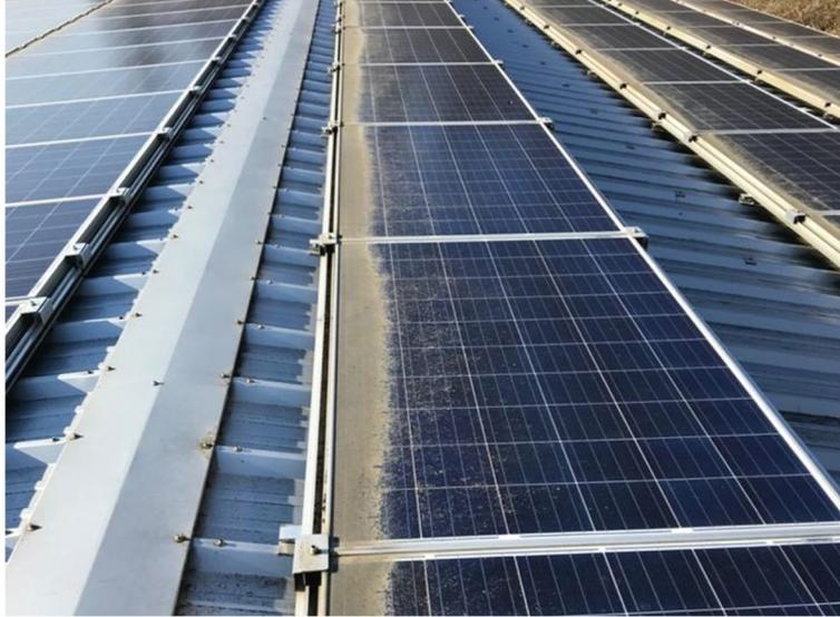
Verschmutzungen durch die Luftverschmutzung, Staubentwicklung, Straßenverkehr, Vogelkot, fallendes Laub oder Nadeln von in der Nähe wachsenden Bäumen können den Solarmodulen auf die Dauer ganz schön zusetzen.
